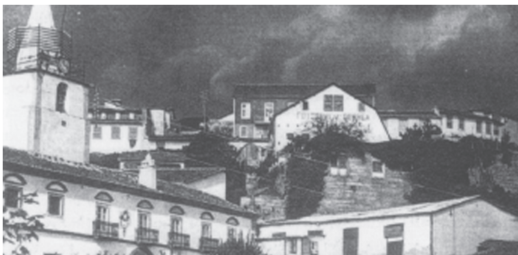
Fig. 2. Fábrica de José Henriques de Castro (a Chapa). Á direita do edifício filipino dos Paços do Concelho, em primeiro plano, o edifício de “A Chapa” e, em segundo plano, a Casa da Hera, ambos destruídos em meados do séc. XX, para a construção do Teatro Cine (inaugurado em 1954) e do novo edifício da Câmara (inaugurado em 1958). Reprodução fotográfica (Saraiva, Madaleno, Pinheiro 2013:109).
