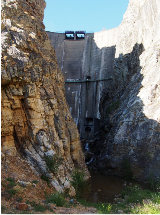
Figura 5 – Aspeto do vale em garganta do rio Unhais, situado a jusante da barragem de Santa Luzia que, em parte, também é visível.
