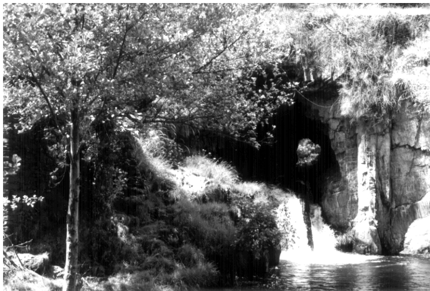
Figura 9 – Túnel do Vale Pardieiro, no rio Ceira, visto de jusante. Notar, à esquerda, encoberta pela árvore, a parede da construção onde funcionava um moinho, que aproveitava o desnível produzido pela queda de água. A “luz ao fundo do túnel” corresponde à abertura situada a montante.
