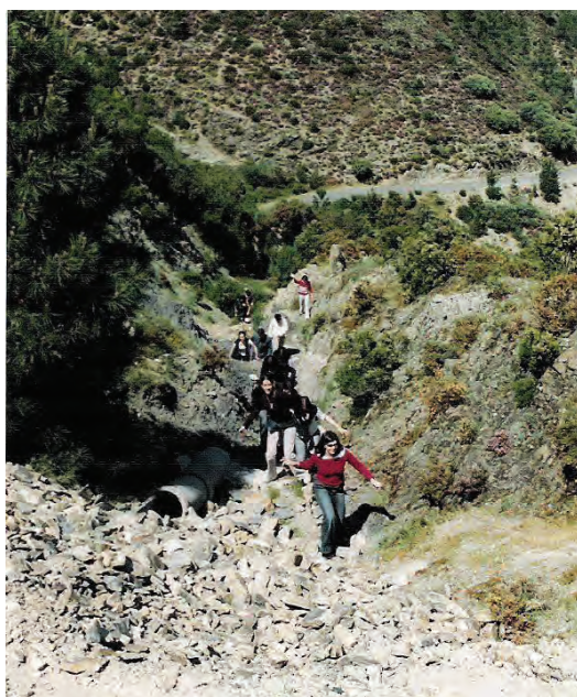
Figura 4 – Pormenor da caixa de falha correspondente ao início da ribeira de Cebola, obtido durante uma das visitas com estudantes da Universidade de Coimbra. Em primeiro plano à esquerda é visível a conduta colocada no topo da caixa de falha, já em mau estado de conservação, que transporta as águas provenientes da área pavimentada.
